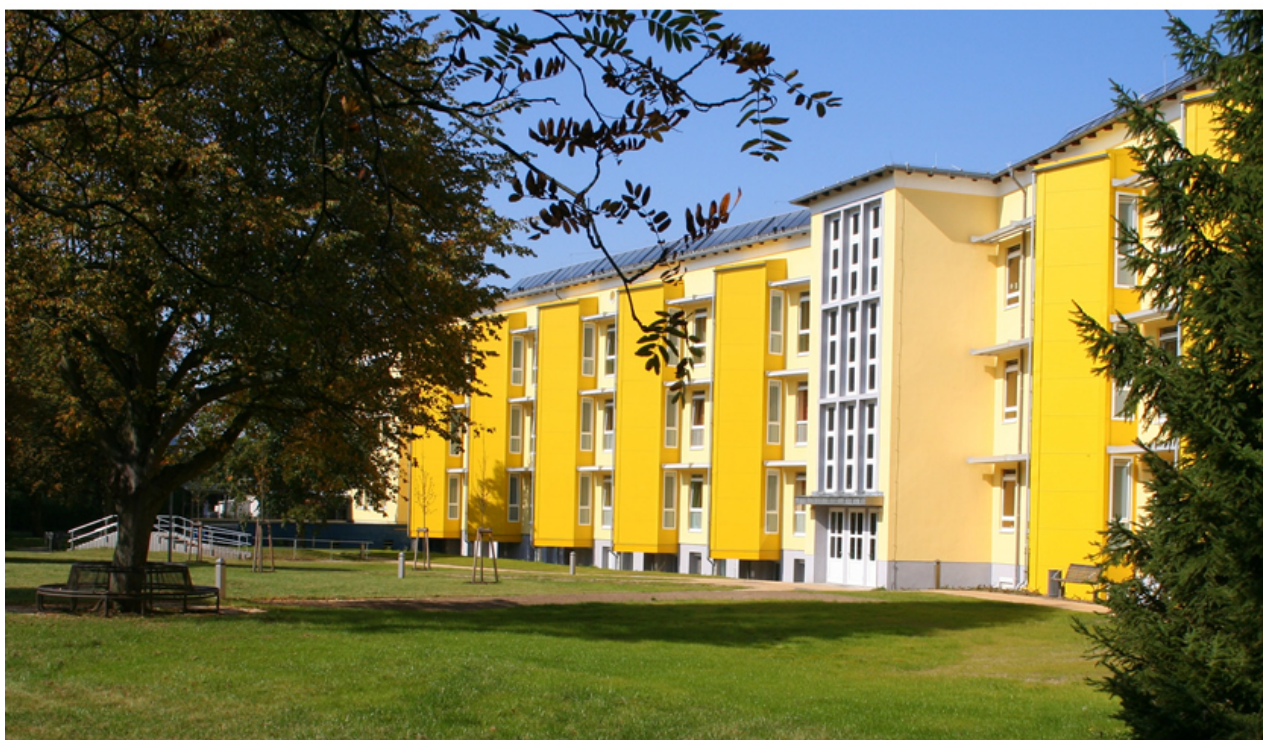
Abbildung: Kreiskrankenhaus Wolgast, Eingangsbereich und Bettenhaus
